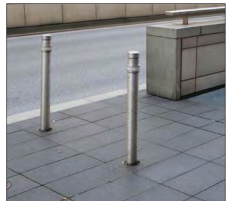
Sperrpfosten aus Edelstahl mit Ziernut und Zierring mit Reflexfolie
